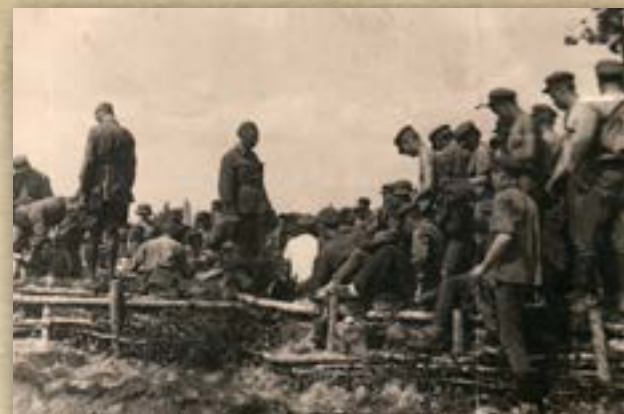
Студенты ЛТИ, возводившие оборонительные сооружения на Лужском рубеже (июль-август 1941 года)
