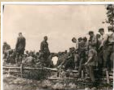
Студенты ЛТИ, возводившие оборонительные сооружения на Лужском рубеже (июль-август 1941 года)
