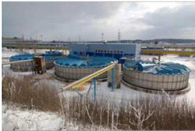
Рисунок 3.4 – Флотаторы для сгущения избыточного активного ила перед обезвоживанием
