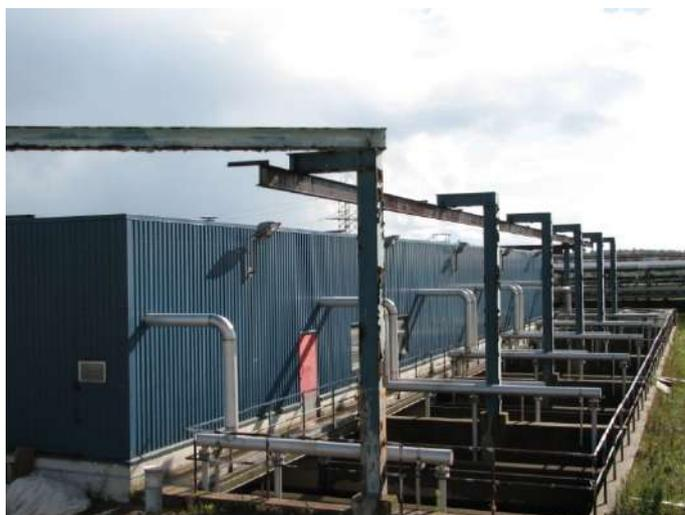
Рисунок 3.2 – Песчаные флотофильтры доочистки сточных вод
