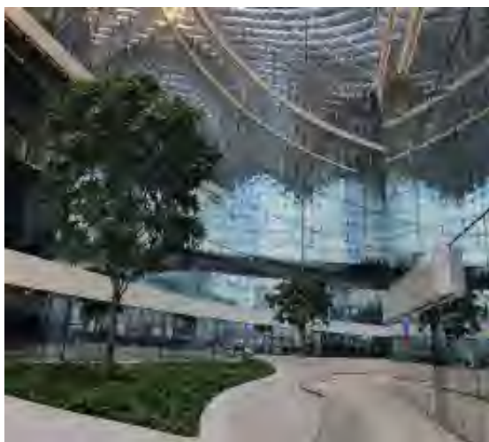
Рис.Б.97. Атриум в Лахта Центре. Санкт-Петербург. Арх. Exclusiva Design. 2011 (фото из открытых источников)
