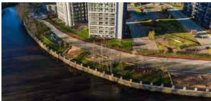
Рис.Б.128, Б.129. Набережная около ЖК «Магника». Санкт-Петербург. Арх. Arteza + Bonava. 2020 (фото из открытых источников)
