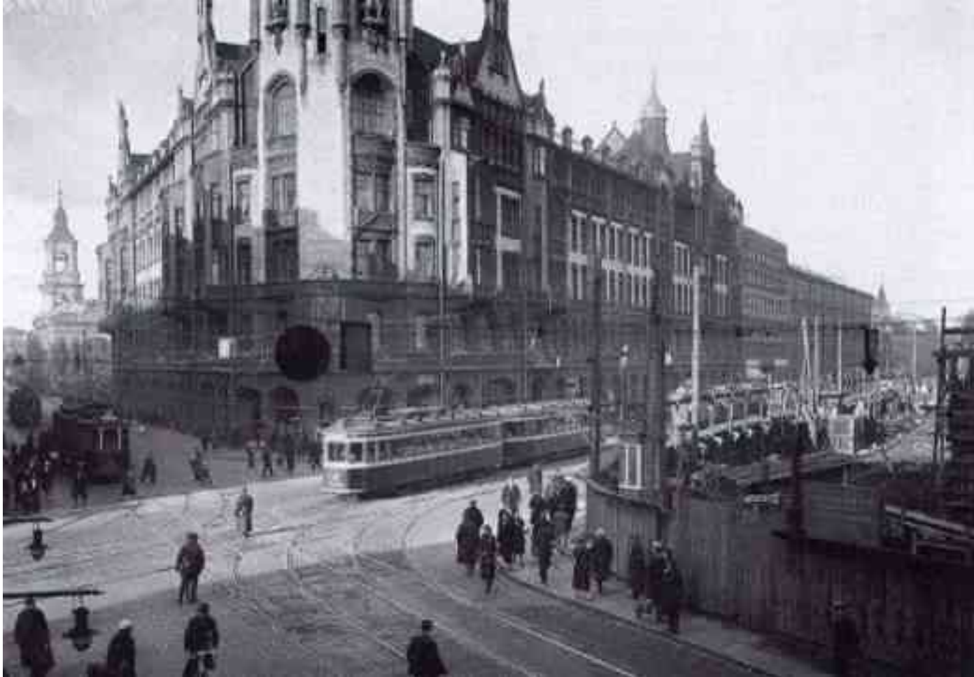
Ил. 284. Строительство здания на проспекте Майорова (Вознесенский проспект, 46). 1936.
